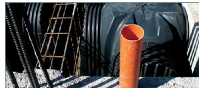
Exemplo de fundação ventilada com sub-grade reforçada
